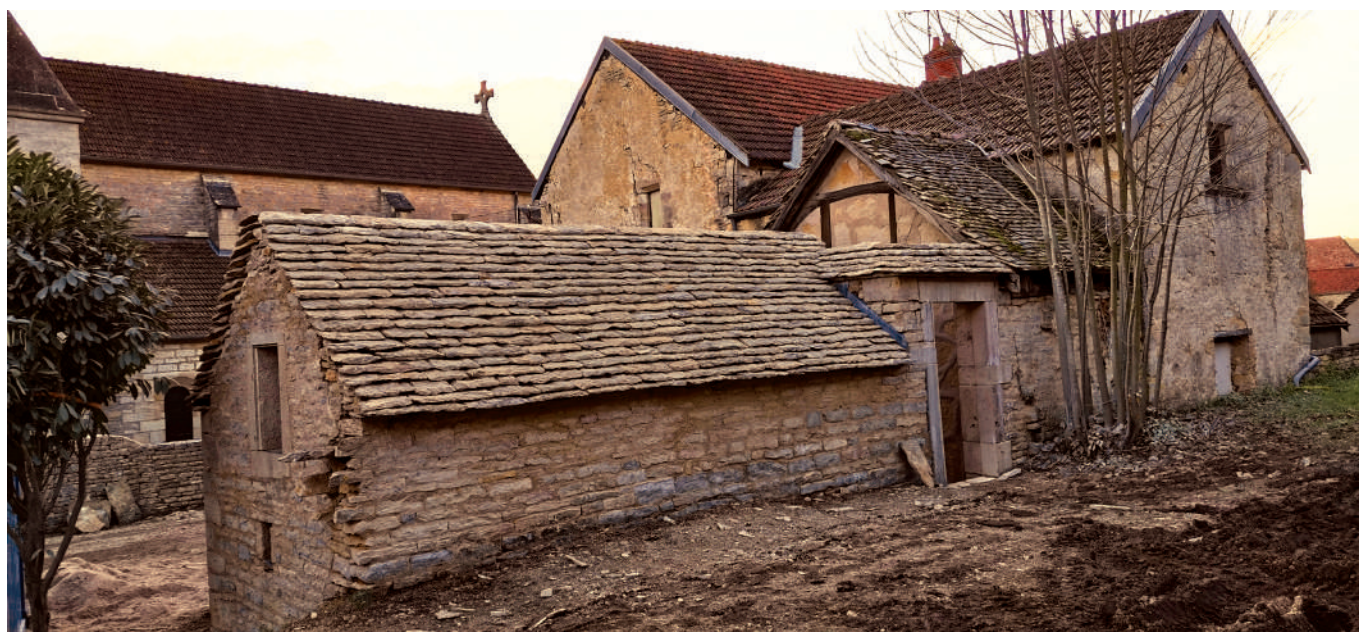
À Fleurey, cet ensemble soue à cochons, poulailler et remise, est un exemple caractéristique du petit patrimoine de pays. Sauvé de la ruine par la restauration récente de son toit en laves, il sera transmis aux générations futures.
